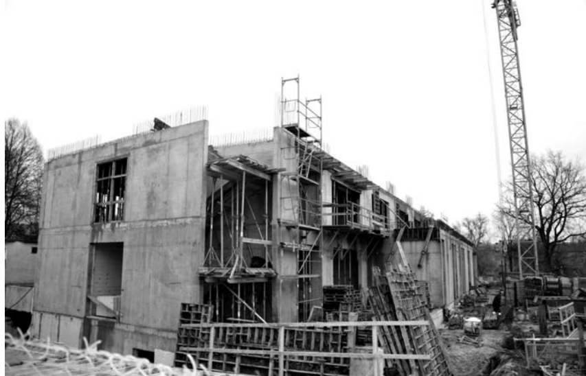
Budowa nowej siedziby WNS, fot.: MM
